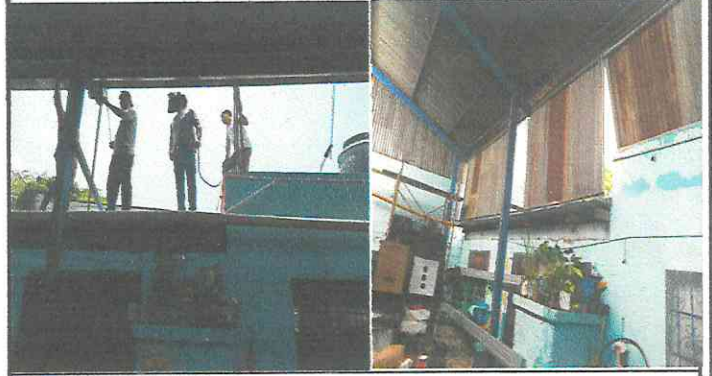
Foto 2: Cubierta de lámina
